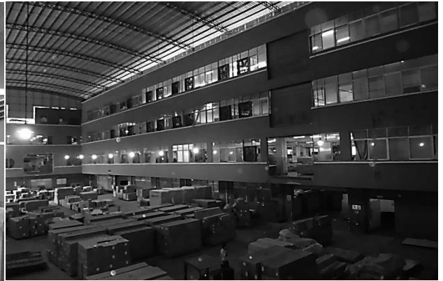
工場建屋内部の様子。ストックヤードを囲むように、各階に生産ラインが設けられている。
